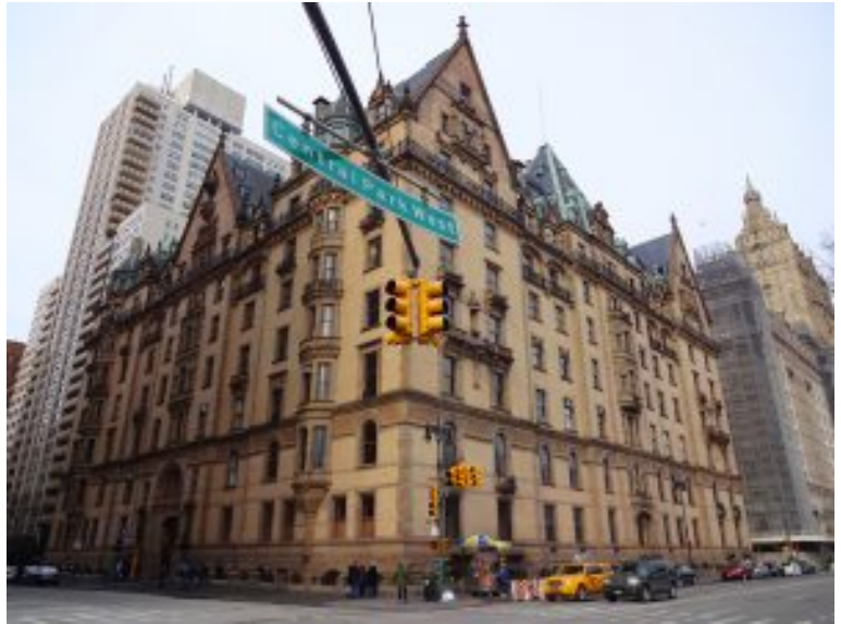
Edificio Dakota en Nueva York
